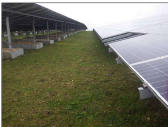
Photo 6: Absence de trace de ruissellement en pied de panneau, sur sol peu perméable (couverture de la décharge de Dijon Nord)
